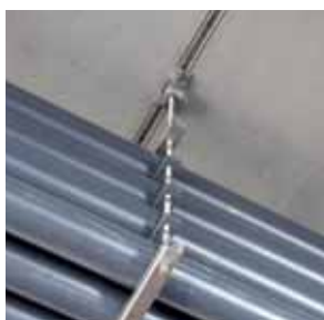
Befestigung von Rohrleitungen
