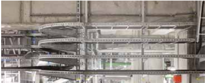
Befestigung von Kabeltragsystemen
