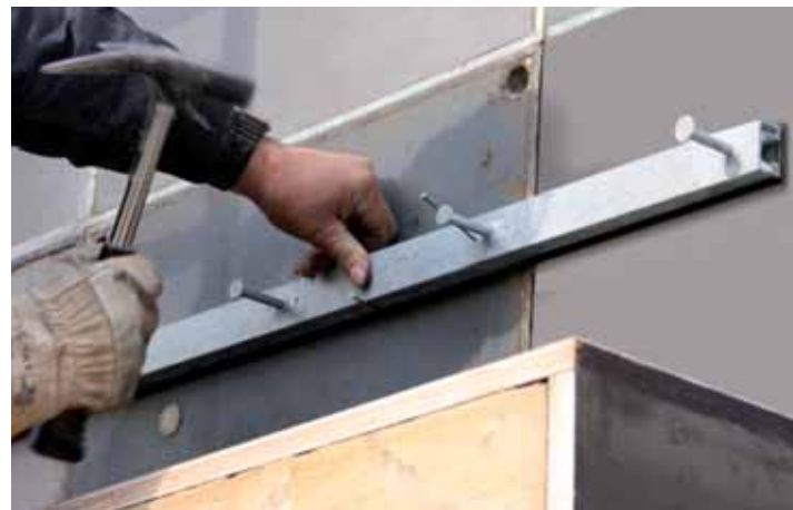
Annageln der Ankerschiene an die Holzschalung
