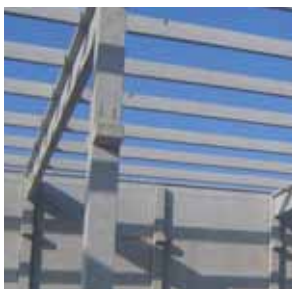
Verbindung von Betonfertigteilen
