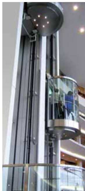
Befestigung der Aufzugsführungs-schielenkonstruktion
