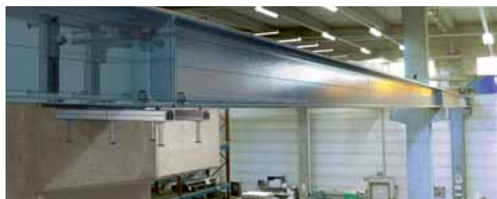
Befestigung von Kranbahnschienen an Betonfertigteilen
