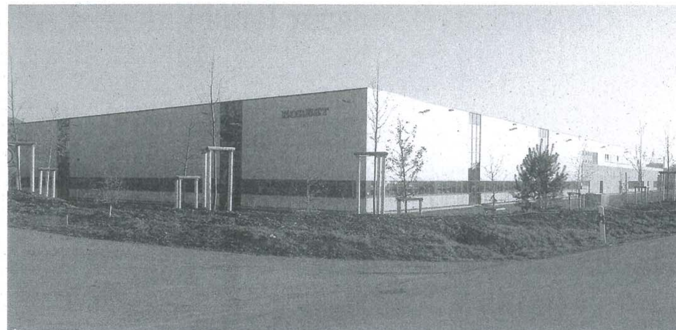
Auf 13 300 m 2 baute der Räderproduzent Borbet eine neue Produktionshalle. Zur Befestigung der über 15 000 m 2 Dach- und Fassadenfläche nutzte die Karl Ulrich Bauunternehmung Jordahl-Trapezblechbefestigungsschienen.
