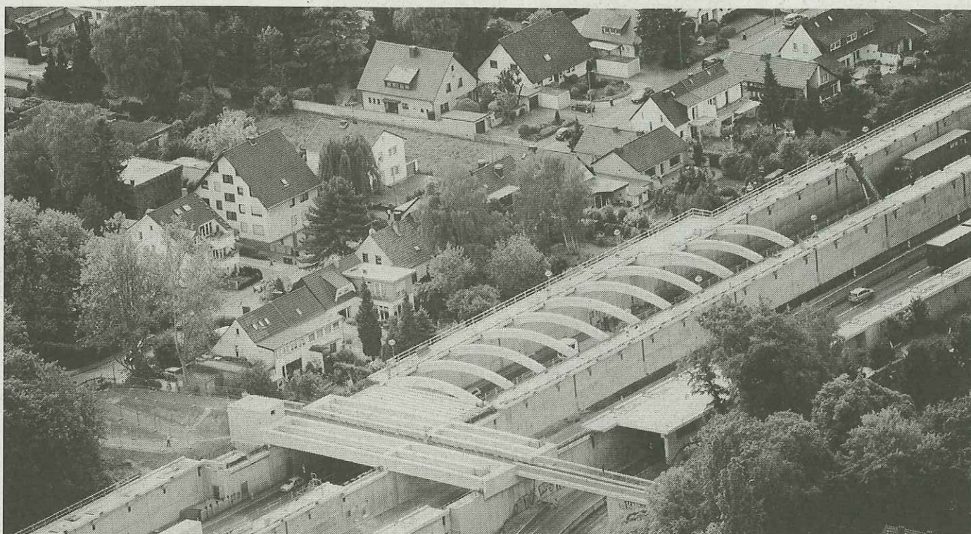
Kostengünstiger als ein Tunnel und dennoch effektiv – die Lärmschutzeinhausung Lövenich an der A 1 geht der Vollendung entgegen.
