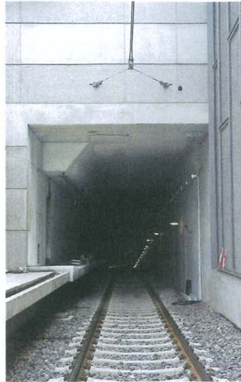
Einfahrt in den bergmännischen Tunnel der Stuttgarter U 6
