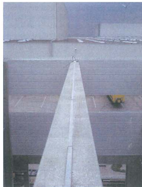
Einbetonierte Trapezblech-Befestigungsschiene im Dachbereich
