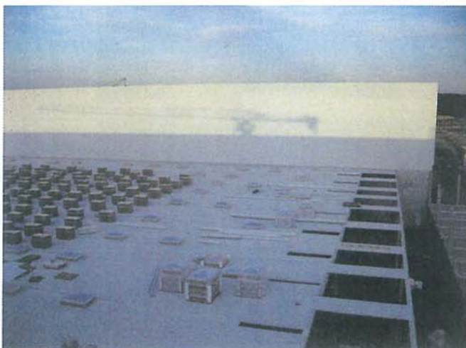
Zur Befestigung der über 151.000 Quadratmeter Trapezbleche an Dach und Fassade nutzt die Klebl GmbH JORDAHL®-Trapezblech-Befestigungsschienen.
