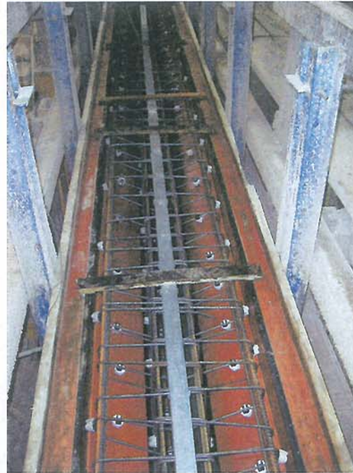
Die Befestigungsschienen für die Trapezbleche sind zum Einbetonieren vorbereitet.
