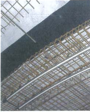
Bild 3. Ankerschienen sind direkt in die Bewehrung eingebaut; eventuelle Kurzschlussströme werden sicher abgeleitet
