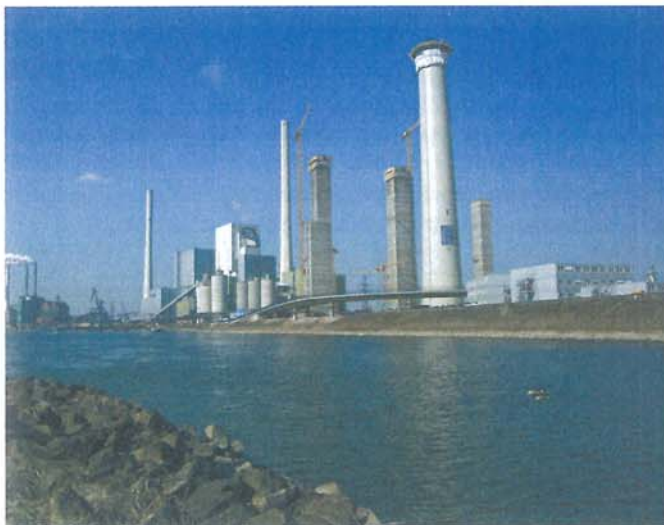
Bild 1. Der neue Steinkohleblock im Großkraftwerk Mannheim wird nach seiner Fertigstellung zu den weltweit modernsten gehören – der 180 m hohe Schornstein und die 120 m hohen Treppentürme bestimmen die Silhouette des Rohbaus
