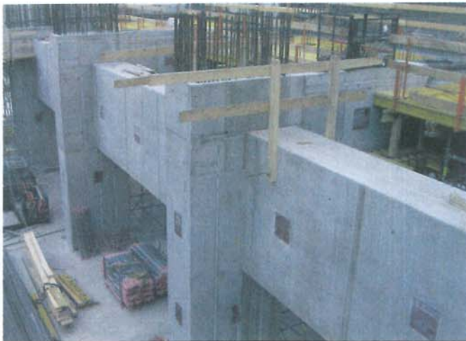
Bild 3. JORDAHL®-Ankerschienen werden oberflächenbündig einbetoniert, Beschädigungen des Baukörpers – wie bei Dübeln erforderlich – werden ausgeschlossen (Fotos 2, 3: Biffinger Berger, Westermann)
