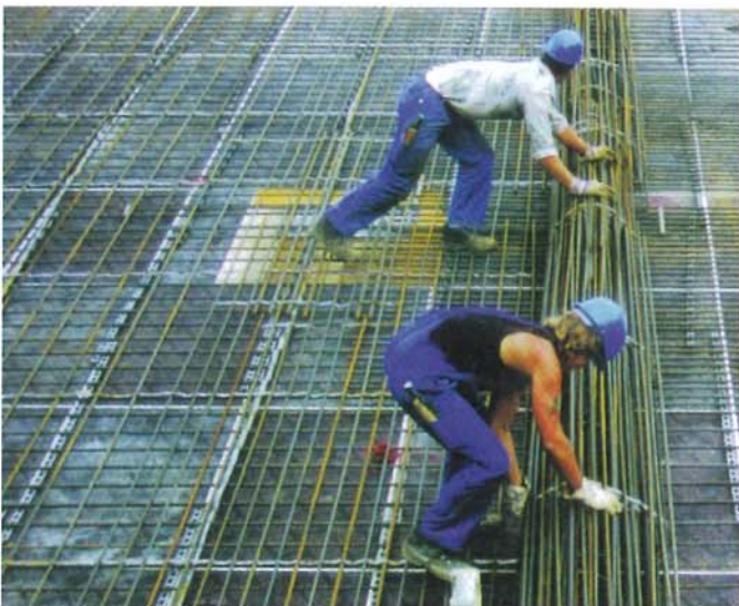
Ausrollen der BAMTEC-Bewehrung
