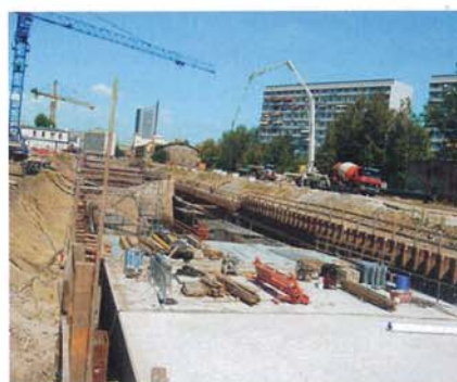
Unter bautechnischer Verantwortung der Firma Jordahl: Ausbau der Tunneldecke am Citytunnel Leipzig.
