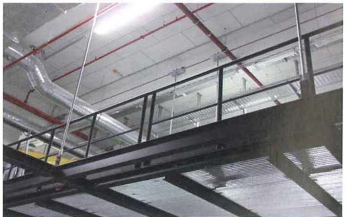
Bild 3. Zwischenetage der Gepackforderanlage (Fotos 2, 3: Deutsche Kahneisen Gesellschaft)
