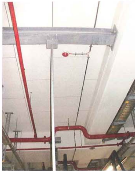
Bild 1. Befestigung der Doppel-T-Trager an JORDAHL®-Ankerschienen JTA W 74/48 (Foto: BAM Deutschland AG)
