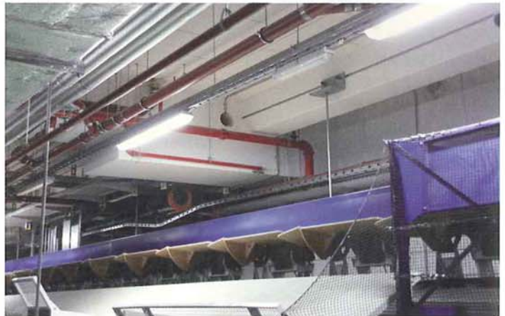
Bild 2. Winkelkonstruktion und JORDAHL®-Ankerschienen JTA W 74/48 zur Befestigung der Abhangung der Zwischenebene der Gepackforderanlage
