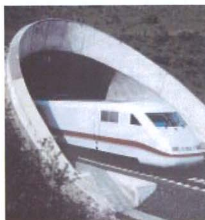
ICE im Tunnel
