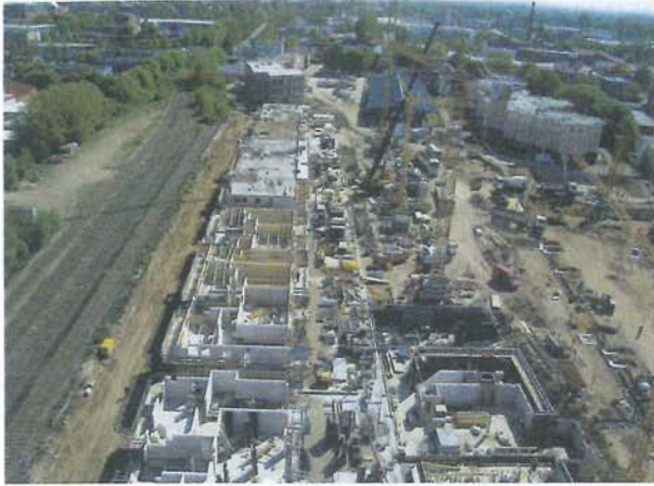
Bild 2. Auf dem ehemaligen Grundstück des Güterverkehrsbahnhofs Hamburg-Bergedorf erfolgt gegenwärtig der Rohbau des Projektes; die HTG Hoch- und Tiefbau Gadebusch GmbH ist hier auch für die Ausführung der Tiefgaragen zuständig (Fotos 1 und 2: Bouwfonds Hamburg GmbH)
