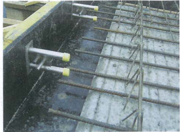
Bild 4. Einige Decken der Tiefgaragen werden unter zusätzlicher Verwendung vorgefertigter Filigrandecken gebaut; die gedrungene Bauweise der JORDAHL®-Doppelschubdorne ermöglicht auch hier einen unproblematischen Einbau
