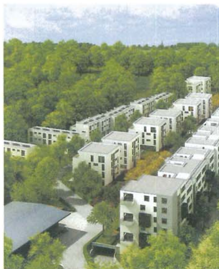
Bild 1. Bis 2011 werden beim Hamburger Projekt Bergedorf.21 insgesamt 317 Wohneinheiten entstehen – unter den Wohngebäuden befinden sich großzügige, teilweise zusammenhängende Tiefgaragen
