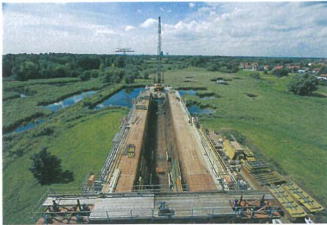
Bild 1. Saale-Elster-Talbrücke in „Vor-Kopf-Bauweise“: Die Auenlandschaft darf beim Bau nicht betreten oder befahren werden
