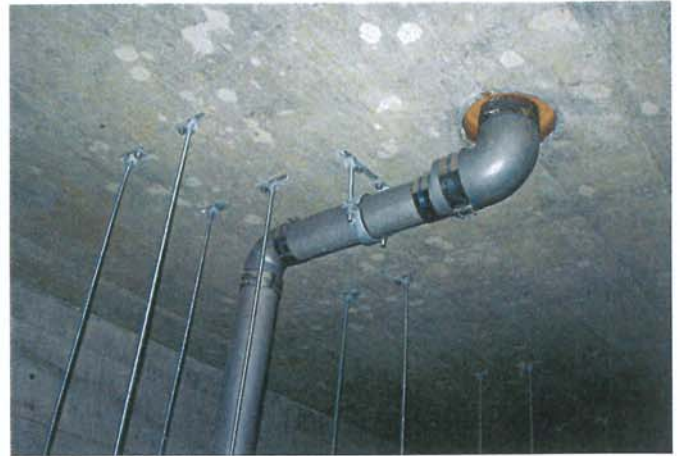
Bild 3. Entwässerungsleitungen und andere Bauwerksausstattungen werden bei der Saale-Elster-Talbrücke an Ankerschienen sicher befestigt, Bau- und Montageteranzen können problemlos ausgeglichen werden (Foto: ADAM HÖRNIG Baugesellschaft mbH & Co. KG)
