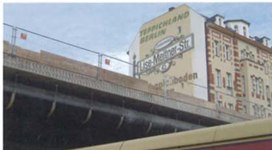
Jordahl-Ankerschienen – flexible und sichere Befestigung von Medienleitungen unter Brücken (Foto: Deutsche Kahneisen Gesellschaft)
