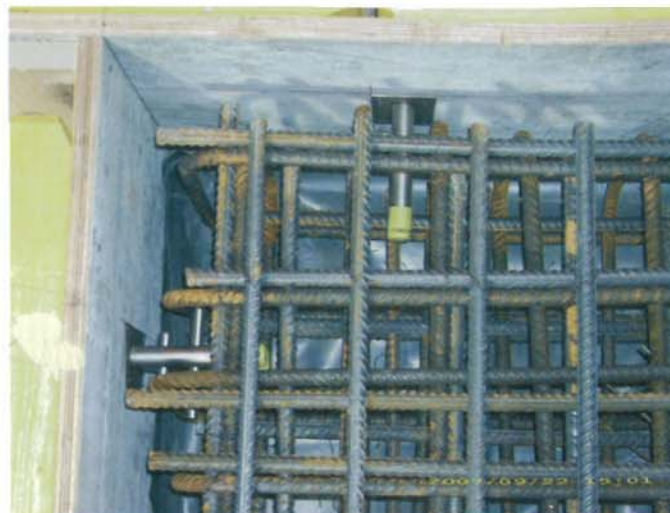
Bild 3. Die Doppelschubdorne sind mit der Bewehrung zum Einbetonieren vorbereitet (Bilder 1, 3: Baubetrieb Berndsen, Bild 2: Deutsche Kahneisen Gesellschaft)
