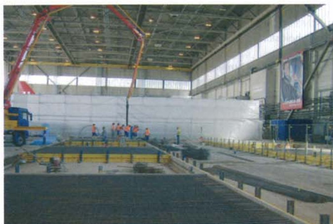
Bild 1. In der fußballgroßen Halle 8 des Düsseldorfer Flughafens wurde der Betonboden in zwei Bauabschnitten komplett saniert
