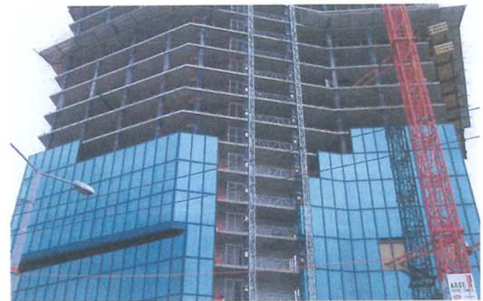
Bild 3. Die Montage der vorproduzierten Fassadenelemente folgt dem Rohbau im Abstand von sieben bis zehn Wochen
