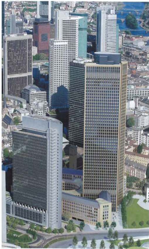
Das künftige Eingangstor zum Europaviertel in Frankfurt/Main: Der 50-geschossige Tower 185. Mindestens 25 Prozent der Energiekosten eines „normalen“ Hochhauses soll der Tower nach Architekt Mäckler einsparen.
