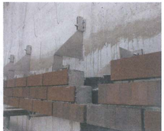
Bild 2. Die JORDAHL®-Konsolen ermöglichen eine unsichtbare Abfangung der Auflasten aus dem Klinkermauerwerk (Deutsche Kahneisen Gesellschaft mbH)
