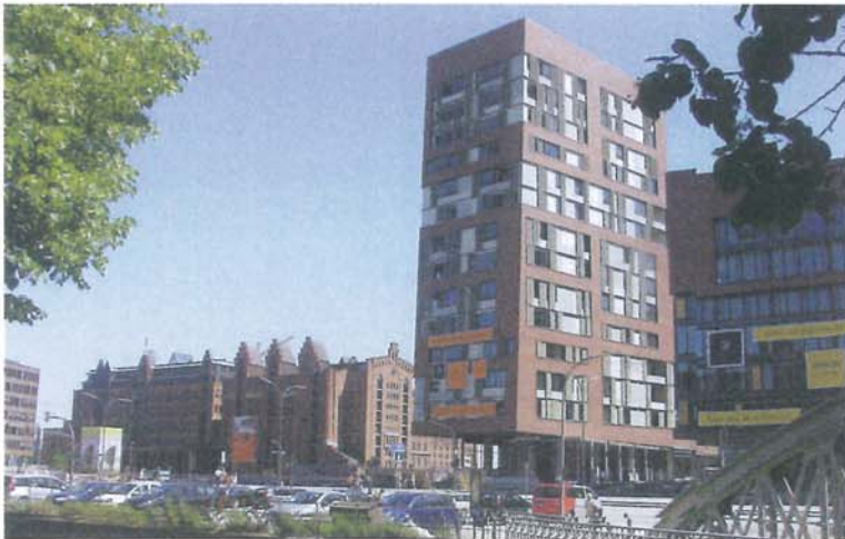
Bild 1. Haus „Arabica“ – „vertikaler Eintritt“ in das neu entstehende Hamburger Überseequartier mit architektonisch interessanter Fassade aus Glückstädter Klinker in Fuß-Sortierung (Foto: Zamzow, ZBP, Berlin)
