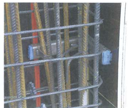
Bild 2. Ankerschienen wurden bei den Stahlbetonstützen in die Bewehrung eingebaut
