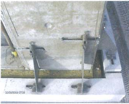
Bild 3. JORDAHL® Verblenderkonsolen sichern im Verbund mit Ankerschienen und Fertigteilhaltern die sichere Befestigung der bis zu 1,5 t schweren Fertigbetonteile (Fotos 2 und 3: DIRINGER & SCHEIDEL, Lintz)
