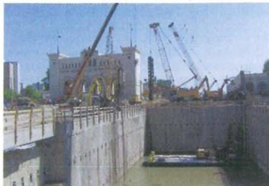
City-Tunnel Leipzig – Baustelle am Bayerischen Bahnhof
