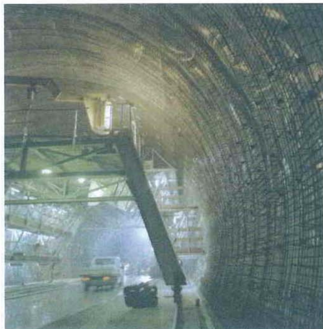
3 Ankerschienen sind direkt in die Bewehrung eingebaut. Eventuelle Kurzschlussströme werden sicher abgeleitet (Foto: DB AG/Lautenschläger)
