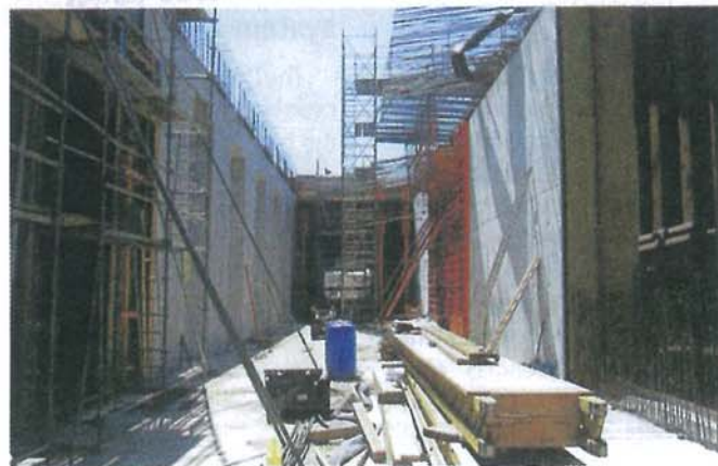
1 Ausbau der Seitenwände an der Tunnelausfahrt
